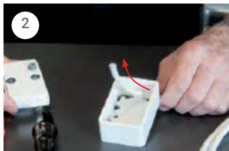
Begynd altid monteringen med at trække antenne-kablet igennem underlag/vægdåse
