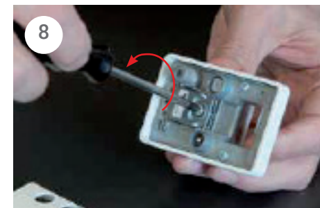
Skruen på dækslet skrues helt løs og løft det herefter op
