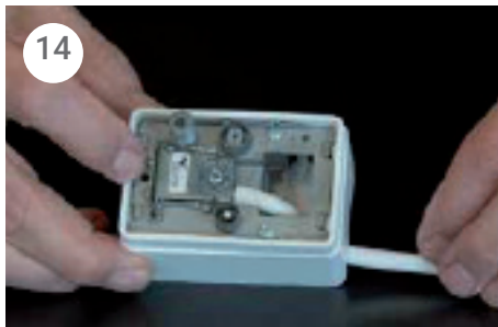
Monter nu antennestikdåsen i underlag/vægdåse
