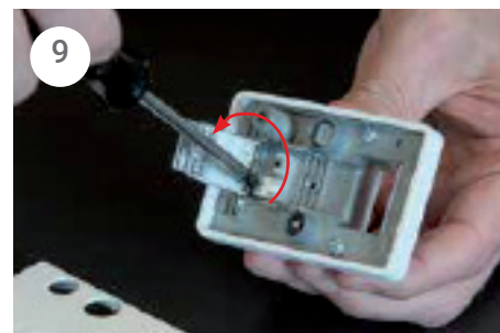
Skruen til inderlederen løsnes
