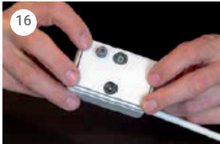
Tryk dækslet fast på antennestikdåsen og TRIAX TD2xx antennestikdåse er færdigmonteret i underlag
